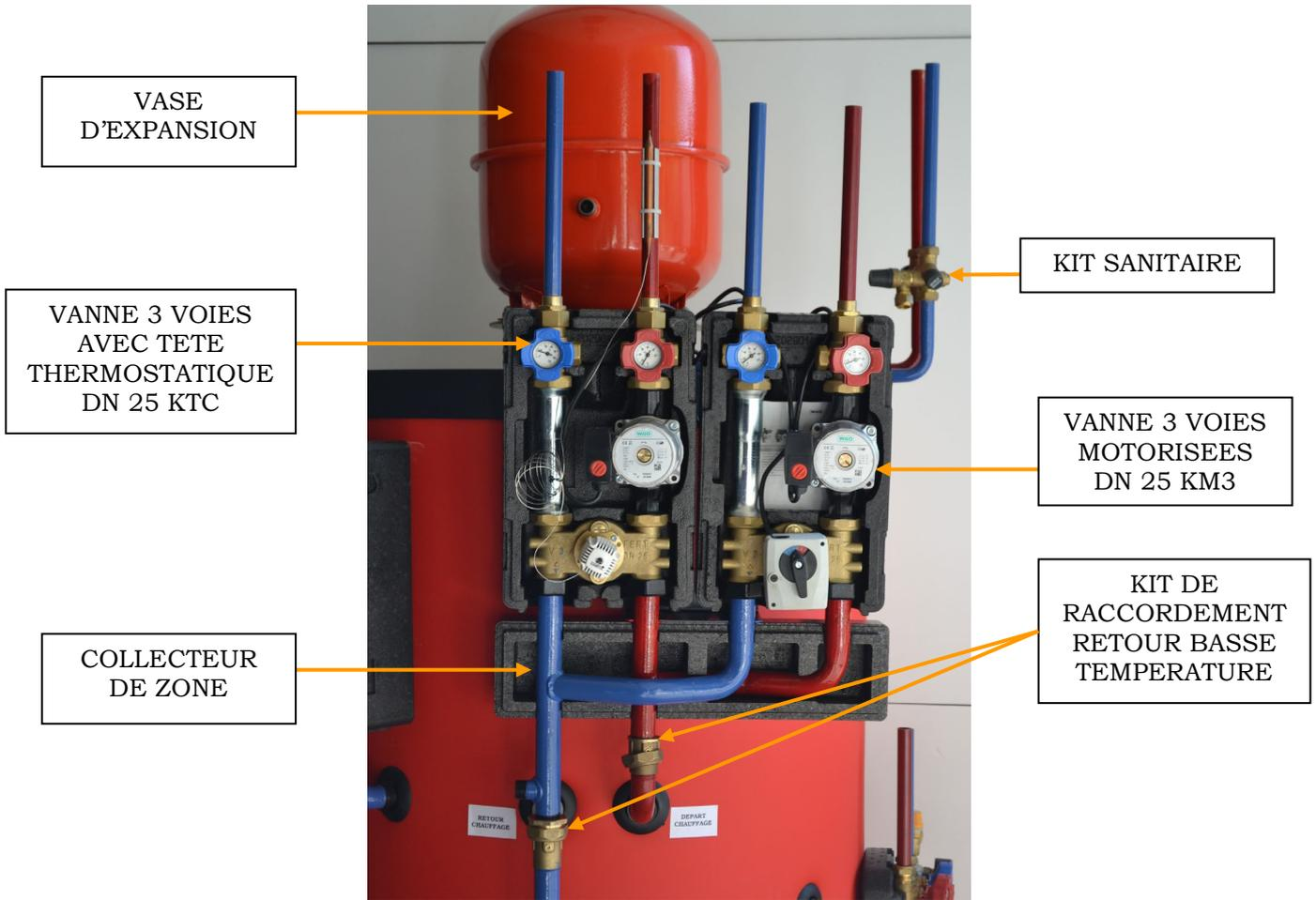
*Schéma hydraulique correspondant à l'équipement du ballon ci-dessus*
