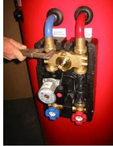
Visser la tête, fixer le bulbe et le thermostat de sécurité (si nécessaire) sur le départ avec les colliers et fixations fournies.
