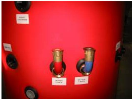
Faire l'étanchéité de l'ensemble des raccords avec de la filasse :
