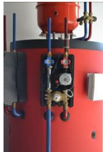
Visser la tête, fixer le bulbe et le thermostat de sécurité (si nécessaire) sur le départ avec les colliers et fixations fournies.
