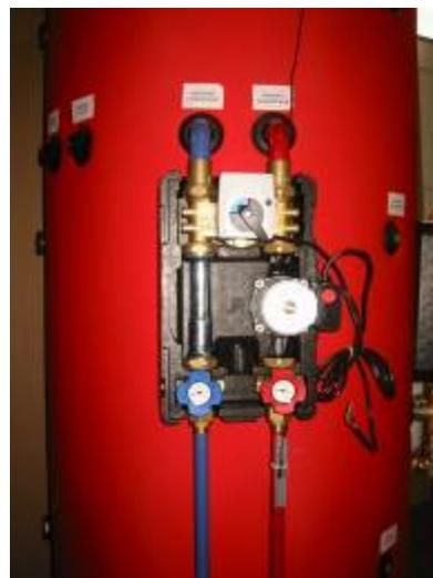
La pose de la motorisation s'effectue en dévissant la tête manuelle et en la remplaçant par celle livrée avec la motorisation :
