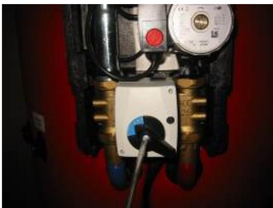
Raccorder le module sur la nourrice de chauffage et fixer la sonde de départ :
