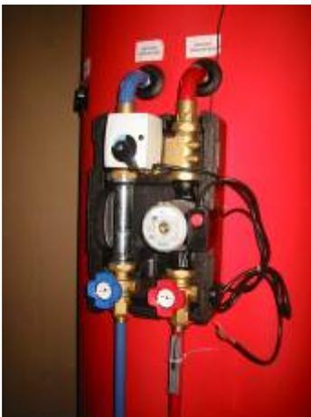
Veillez à bien ouvrir les vannes de raccords avant la mise en service :
