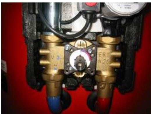
Insérer le moteur en faisant attention au positionnement de la vanne et visser la vis de fixation :
