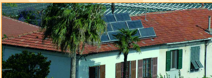
Capteurs TUBO montés sur châssis à l'horizontale, Europe du Sud
