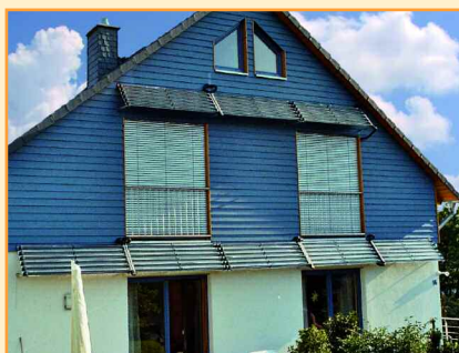
Montage sur façade de 8 panneaux TUBO, Allemagne
